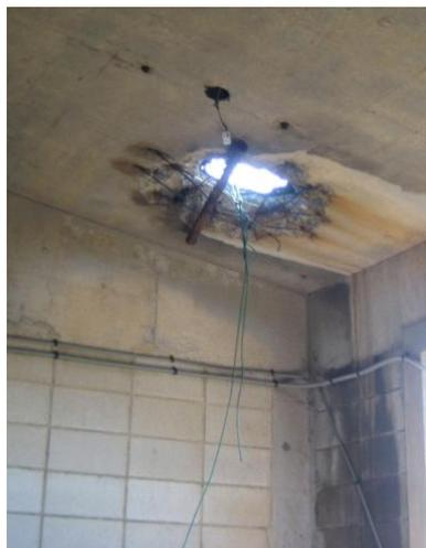
写真 2-1 2000 年三宅島噴火の際に大きな噴石によって被災した建物
