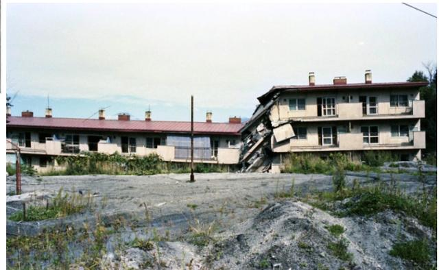
写真2-9 1977～1980年有珠山噴火に伴う地殻変動によって破壊された建物（石原和弘氏撮影）
