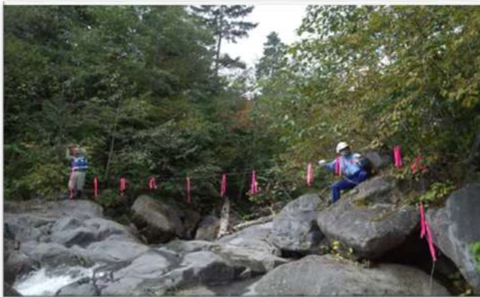
ワイヤーセンサーの設置
