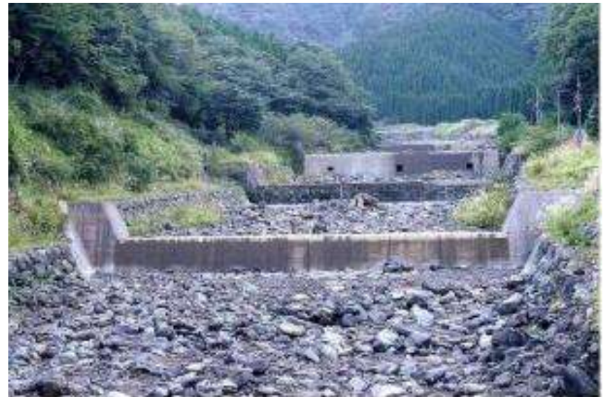
床固工群（霧島山）
