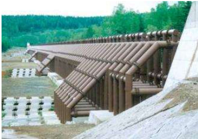
鋼製砂防えん堤（十勝岳）
