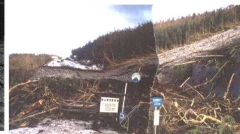
土石流により、5合目付近の富士スバルラインが寸断、6合目の県安全指導センターが被災(山梨県 H3)
