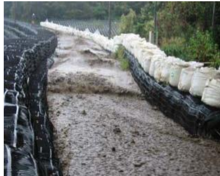
泥流流下のための仮設導流工（三宅島）
