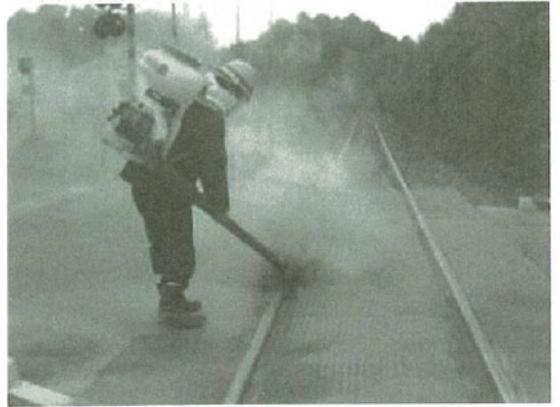
写真-6 灰の除去作業
