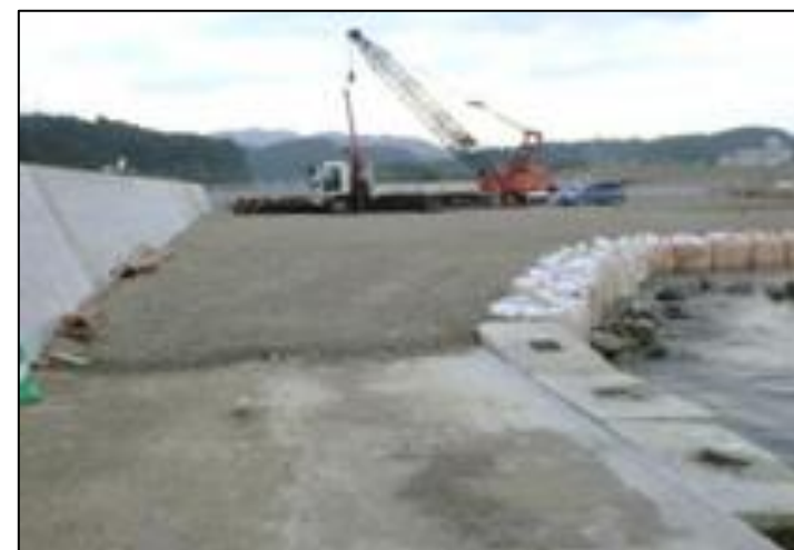
志津川漁港南防波堤復旧工事
