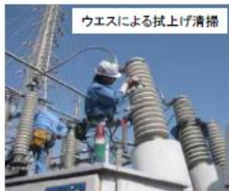
＜降灰除去作業の例＞
