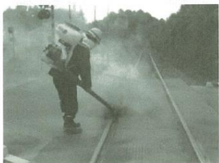
写真－6 灰の除去作業
