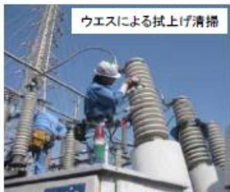
<降灰除去作業の例>
