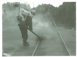
写真－6 灰の除去作業
