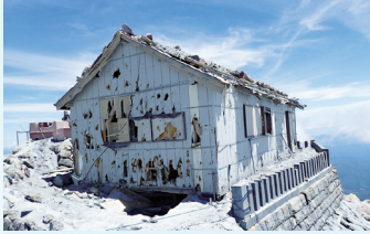
▲ Núi Ontake: Tòa nhà bị hư hại do đá và mảnh vỡ (10 tháng 6 năm 2015) <Ảnh do Nhóm Quan sát Chung Núi Ontake cung cấp>
