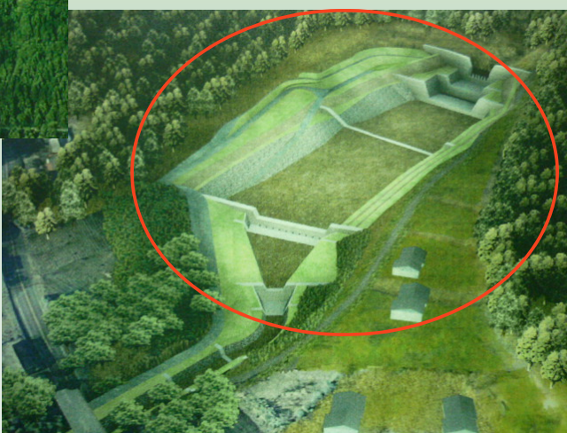
祓川砂防堰堤
