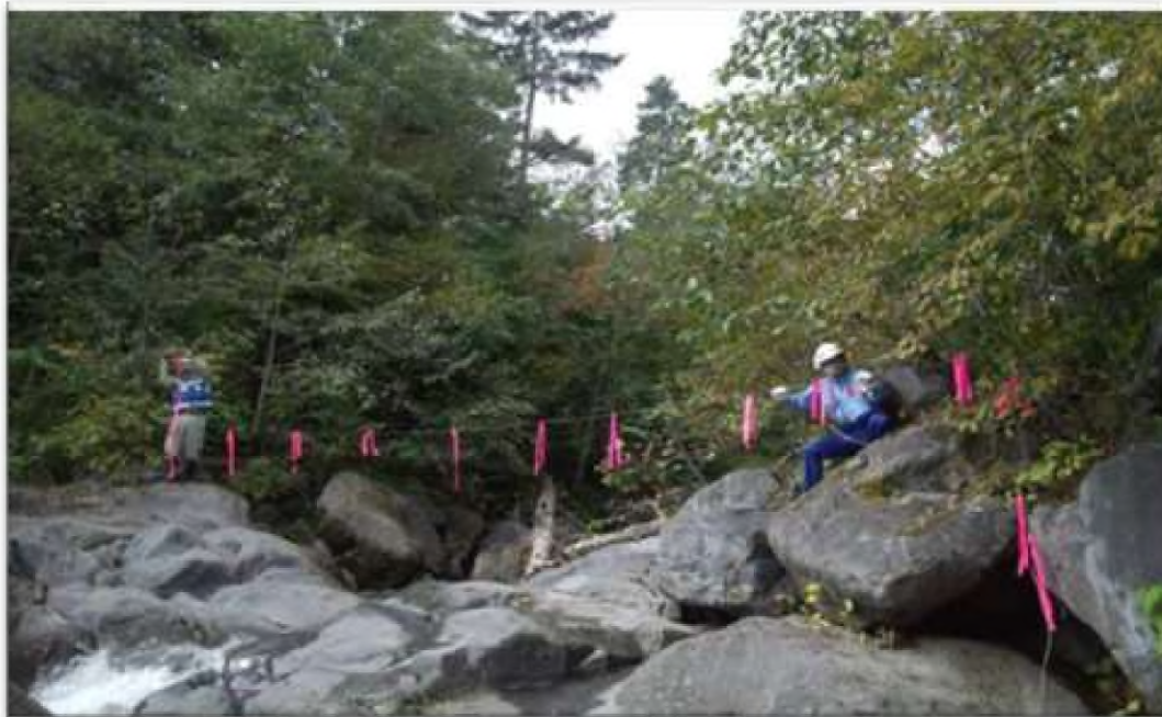
ワイヤーセンサーの設置
