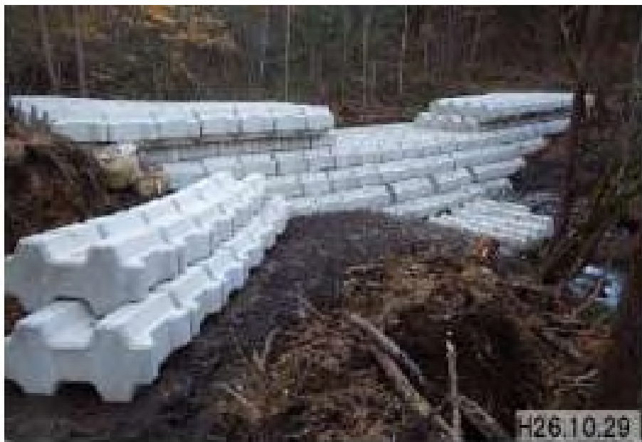
ブロック積による仮設の砂防堰堤（御嶽山）
