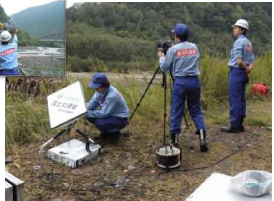
監視カメラの設置
