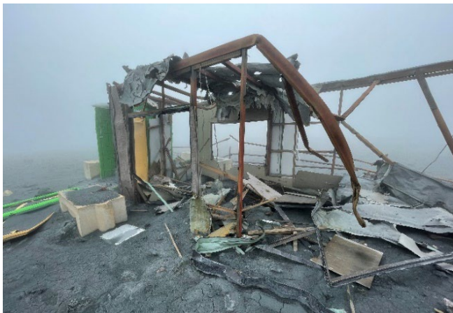
▲二次避難施設整備現場事務所
