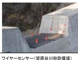
ワイヤーセンサー(望原谷川砂防堰堤)
