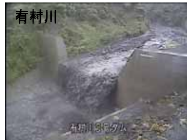
2009年11月1日に発生した土石流
