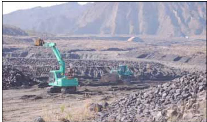
【無人化施工機械を用いた除石】
