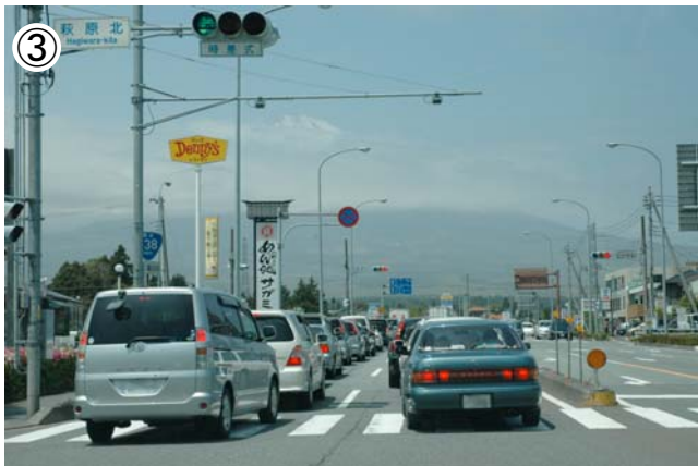
国道 138 号（御殿場市萩原北交差点付近）
