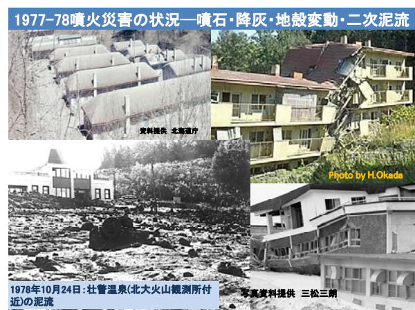
各種の被害状況
