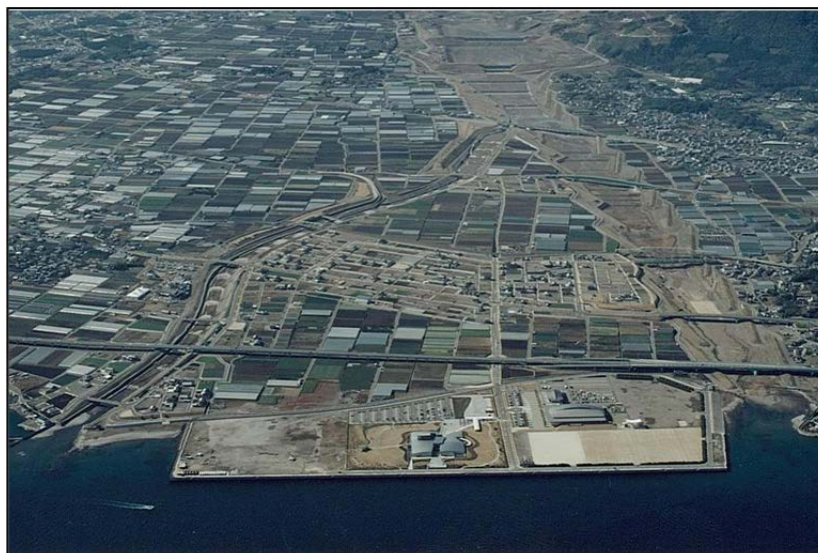
〈安中三角地帯（水無川（左）・導流堤（右）、上奥に砂防堰堤群）
