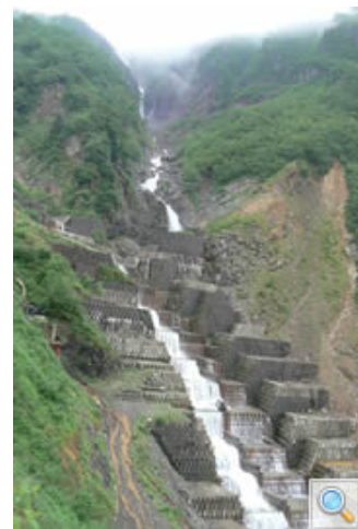
甚之助谷砂防堰堤群
