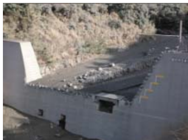
有村川第3砂防堰堤での観測
