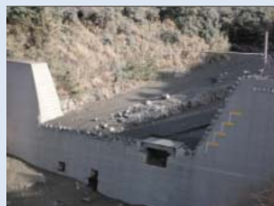
有村川第3砂防堰堤での観測
