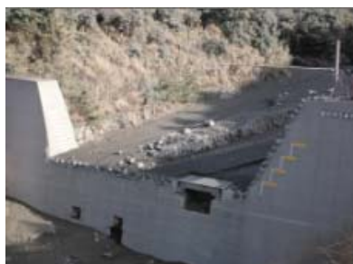
有村川第3砂防堰堤での観測
