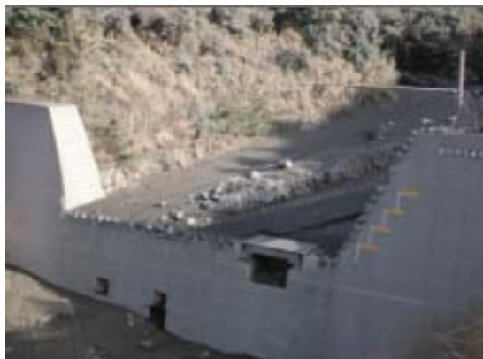
有村川第3砂防堰堤での観測
