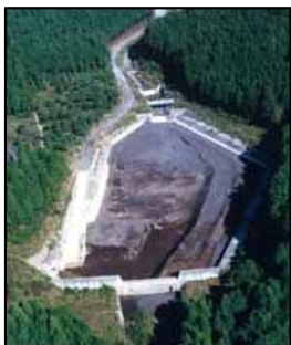
基本ハード対策の例 (沈砂池)
