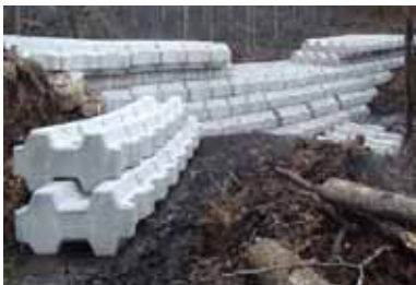
緊急ハード対策の例 (ブロック積み堰堤)
