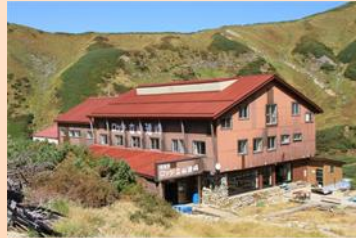
R3年度 民間施設改修 (富山県立山町)
