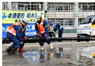
▲水道復旧・給水訓練
