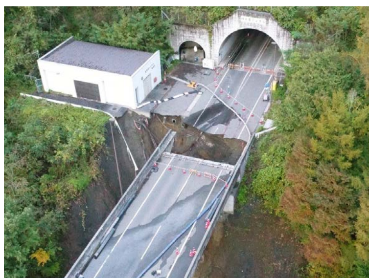
国道361号 上伊那郡南箕輪村北沢山
