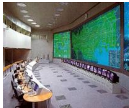
交通管制センター
