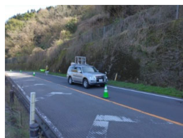
MMS※1を活用した 斜面・のり面点検
