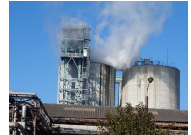
バイオマス発電所で発生した火災
