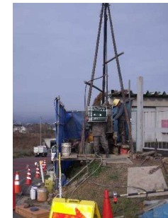
詳細調査 (ボーリング)
