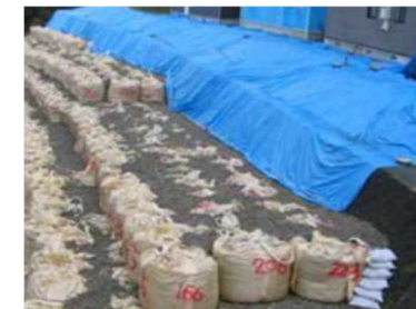
応急対策 (土留工)
