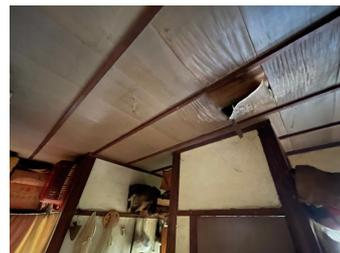
致命的では無いものの、屋根の損傷による雨水の浸水により全体的に天井がたわんでいる状態。
