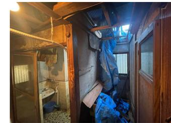
地元工務店による修繕工事が行われたとして、行政の対応は完了とされている。しかし、劣化したシートは破れ空が見える状態のまま
