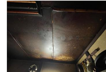
写真ではわかりにくいですが、随所に見られる天井のたわみ。また、廊下には雨漏りした水滴を受けるためのタライが数カ所置かれたままの状態であった。
