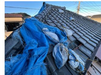
地元工務店の対応後も屋根上に残された劣化シートと土のう袋。劣化したシートの粉が近隣に飛散していた。
