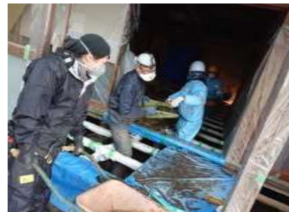
床下の泥の撤去 (宮城県丸森町)
