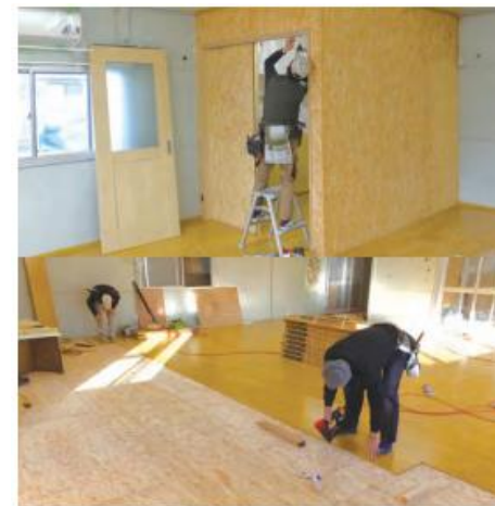
放課後児童クラブ(学童保育)修繕工事の様子
