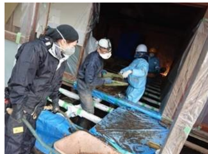
床下の泥の撤去 (宮城県丸森町)
