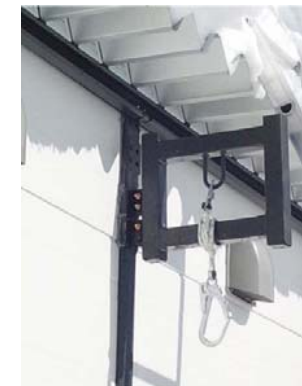
雪下ろしのための 金物の設置
