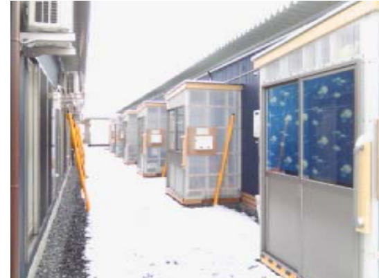
風除室の設置
