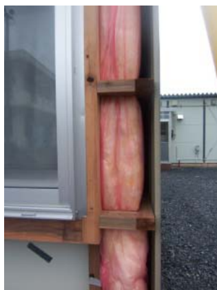
追加工事による 外断熱
