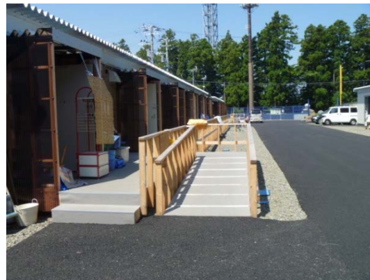
住戸前の舗装、スロープの設置
