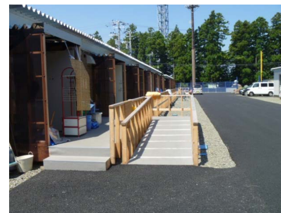
住戸前の舗装、スロープの設置
