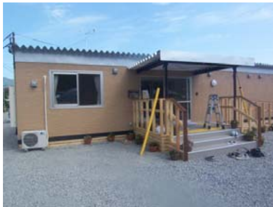
グループホーム型仮設住宅
