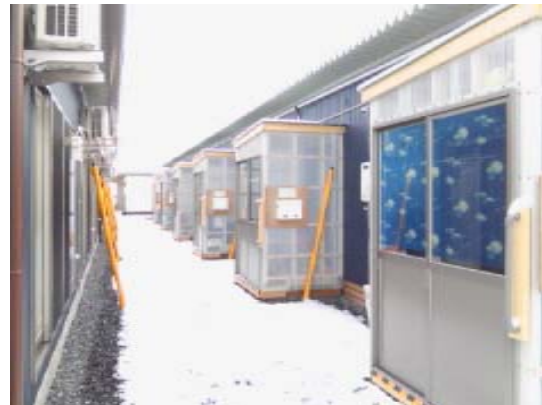
風除室の設置
