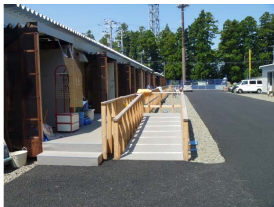
住戸前の舗装、スロープの設置
