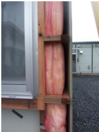
追加工事による 外断熱
