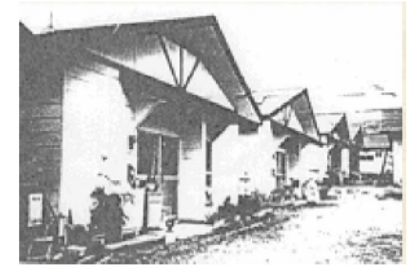
改修による恒久化 ※
