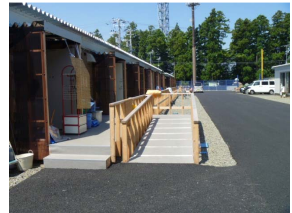
住戸前の舗装、スロープの設置
