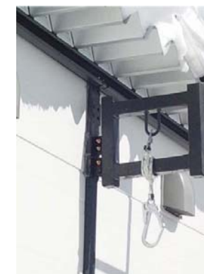
雪下ろしのための 金物の設置
