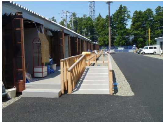
住戸前の舗装、スロープの設置
