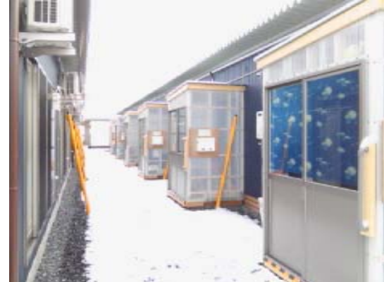
風除室の設置
