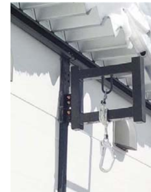
雪下ろしのための 金物の設置
