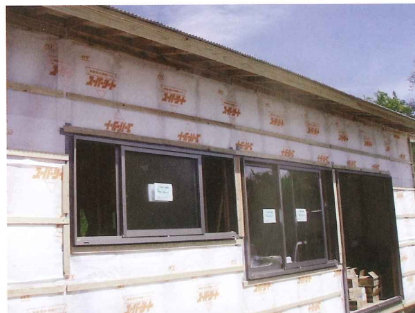
横同縁にて施工(通気層確保)
