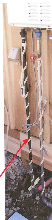
給水立上はヒーター巻き
