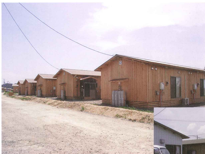
いわき市高久第9応急仮設住宅
