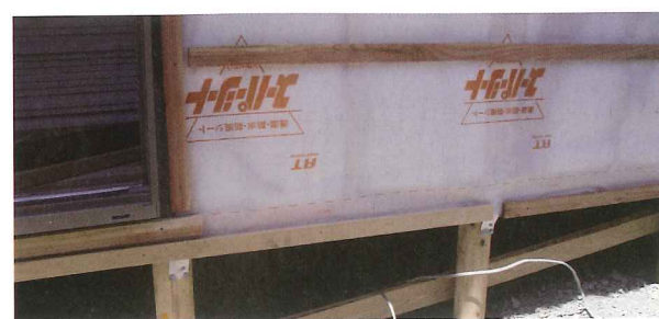
横同縁にて施工(通気層確保)
