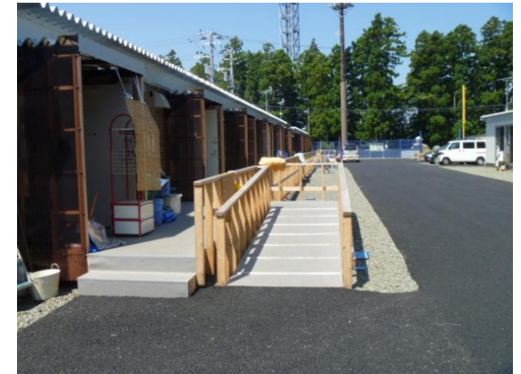
住戸前の舗装、スロープの設置
