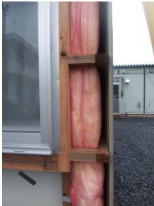
追加工事による 外断熱
