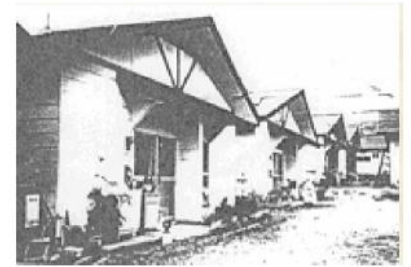
改修による恒久化 ※
