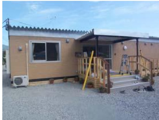
グループホーム型仮設住宅
