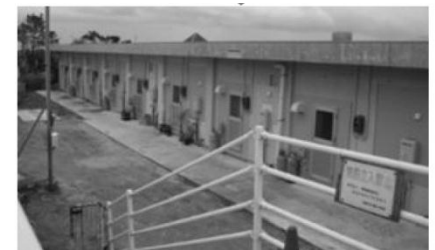
既存建築物の活用
