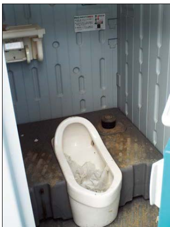
トイレットペーパー が詰まっているトイレ*1
