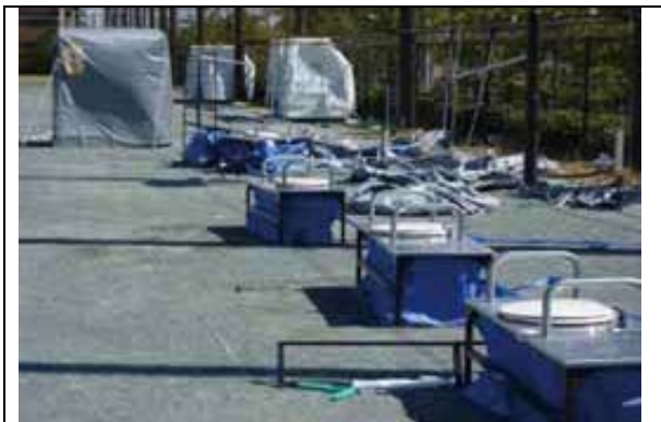
強風で壊れた組立トイレ（浦安市）*2
