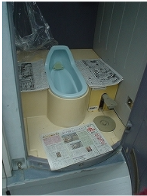
和式便器タイプの災害用トイレ*1 (車いすが入らない、手すりもない)
