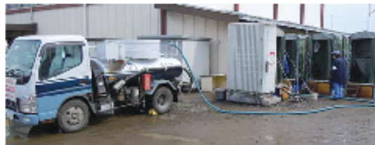
■日本大震災の被災地における災害復旧作業
