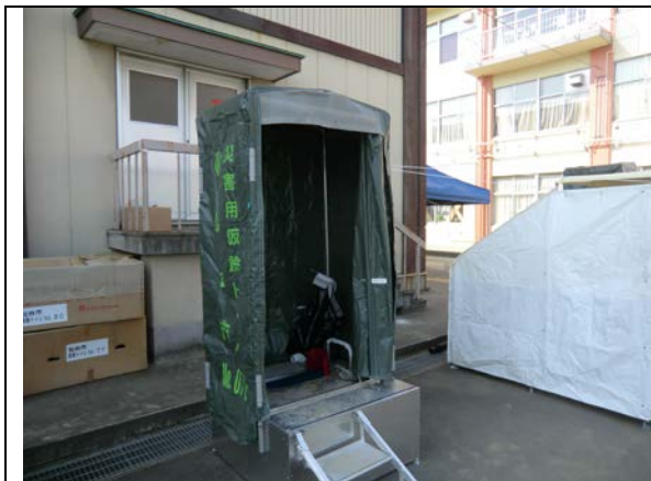
汲み取り型のトイレ (仙台市) *3
