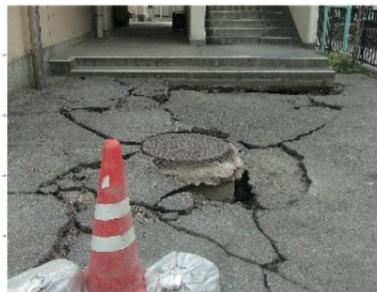
液状化で損壊したマンホール
