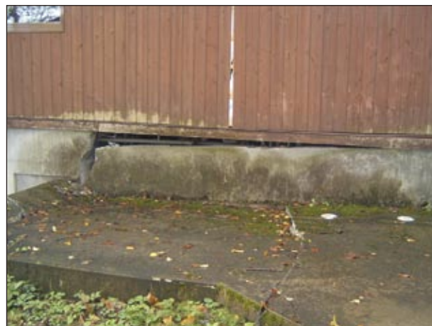
破断し不陸が生じている
