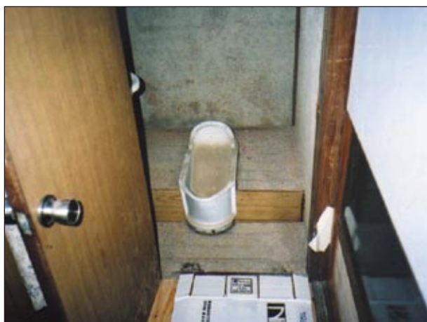
便器：汚損し、配管が詰まっている
