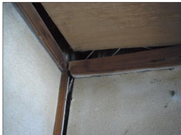
天井板の浮きが生じている
