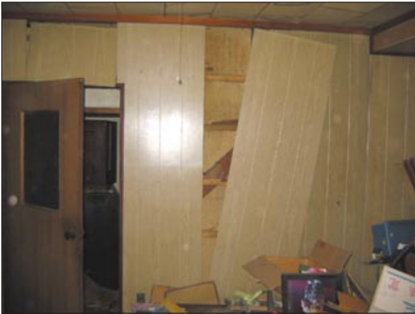
内壁合板に剥離、脱落が見られる
