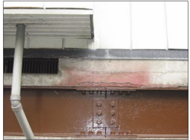
接合部の変形が見られる
