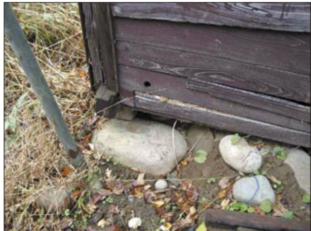
上部構造が玉石から移動している
