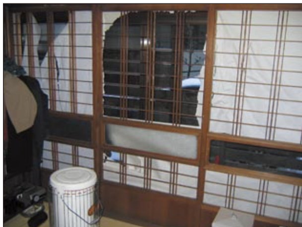
【襖、障子】 障子紙が破損し、張り替えが必要である
