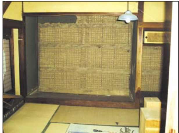
全ての仕上材が脱落している
