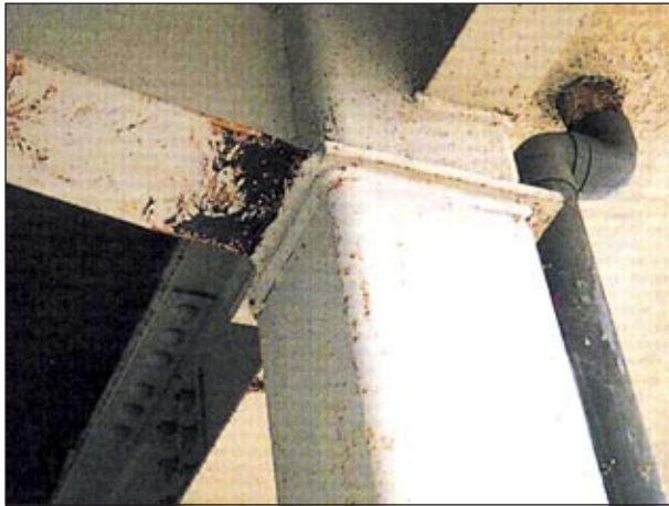
接合部の変形が見られる
