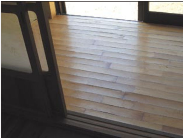
フローリング材の浮き上がりが見られる
