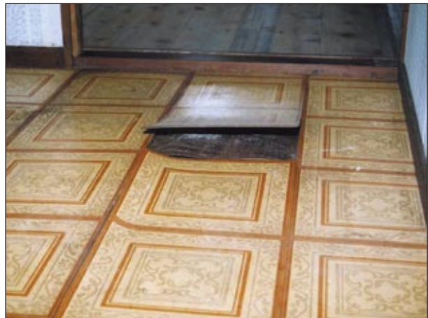
合成樹脂系床材の剥離が見られる
