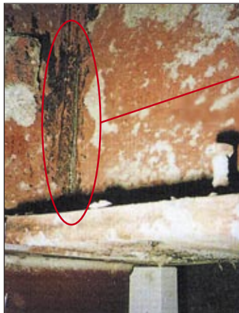
ボルトの一部破断あるいは、接合部の亀裂が見られる
