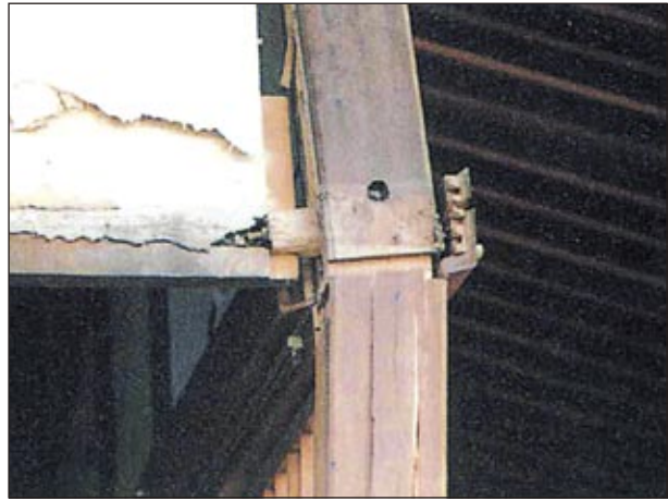
柱、梁の仕口に著しいずれが見られる
