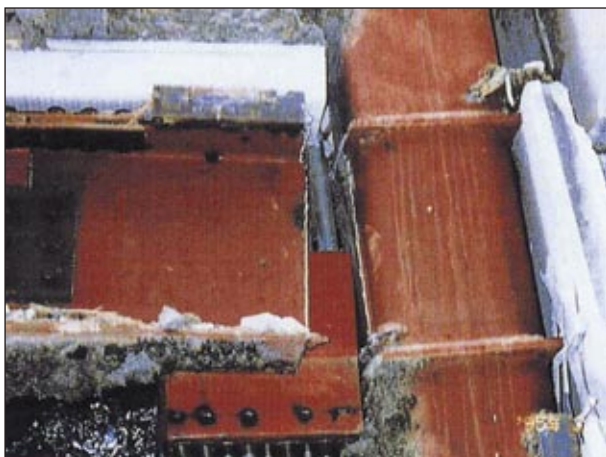
接合部または継手に大きな破断が見られる
