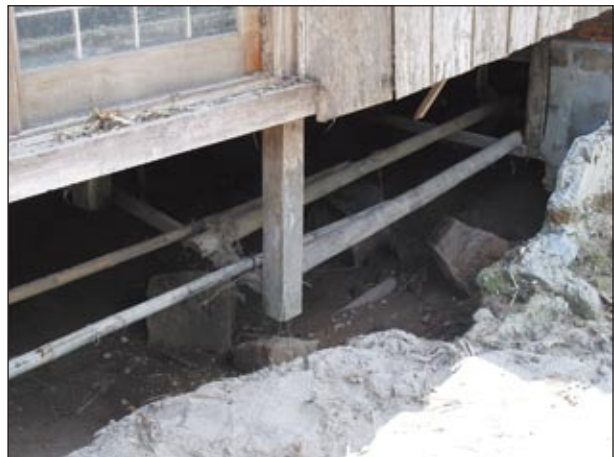
基礎が地盤と共に流出している
