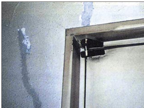
【ドア】 取り付け部がはずれている
