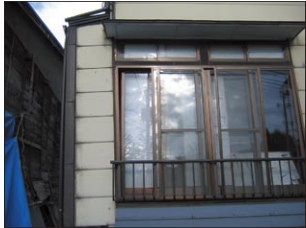
【アルミサッシ】 枠の一部に変形が見られる
