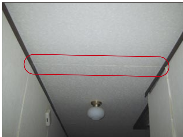
天井板に隙間が生じている
