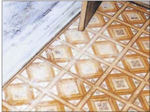
合成樹脂系床材の汚損が見られる
