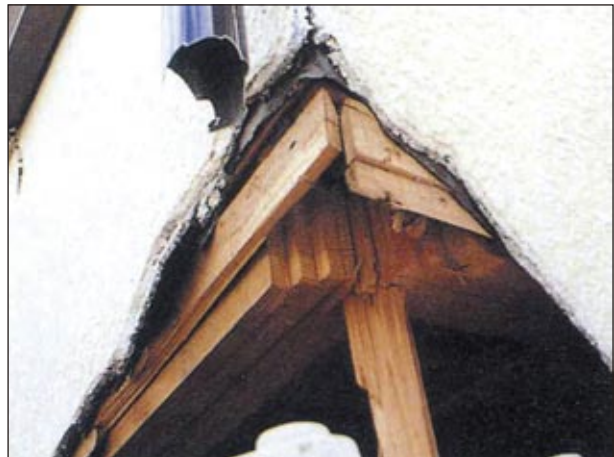
柱、梁に著しい折損が生じており、交換が必要である
