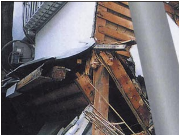
柱、梁の割れ、断面欠損が著しい
