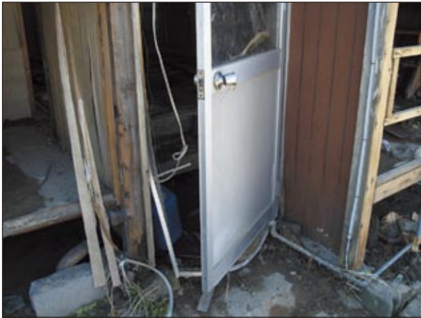
【アルミサッシ】 枠の一部に変形が見られる
