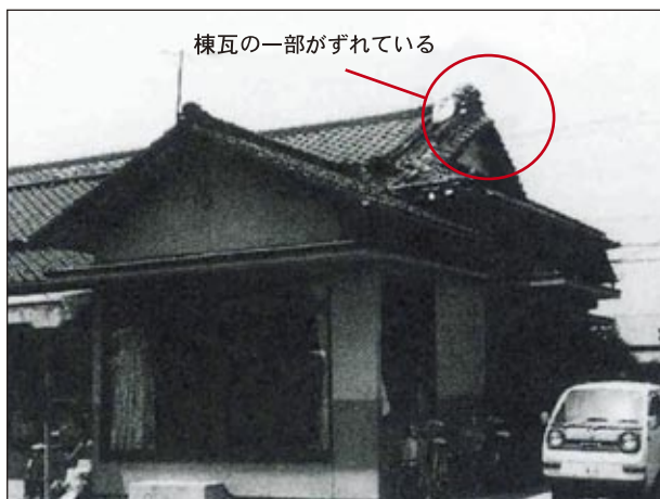
棟瓦（がんぶり瓦、のし瓦）の一部がずれ、破損が生じている
