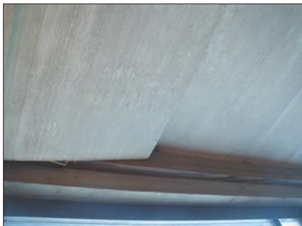
天井板の浮きが生じている
