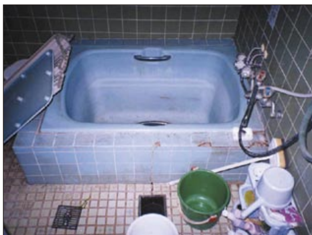
浴槽：汚損し、配管が詰まっている
