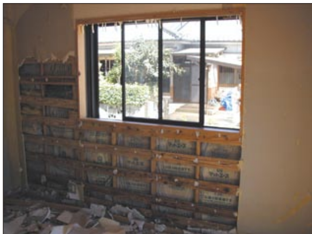
断熱材の吸水による機能損失が見られる
