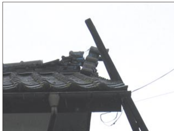
棟瓦（がんぶり瓦、のし瓦）の一部がずれ、破損が生じている
