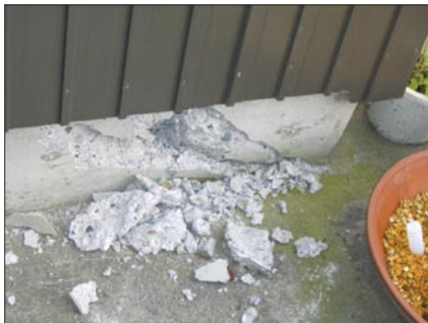
基礎躯体自身の欠損脱落が見られる
