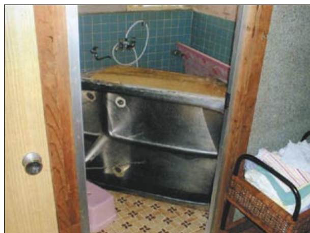
浴槽：転倒し、配管が切れている
