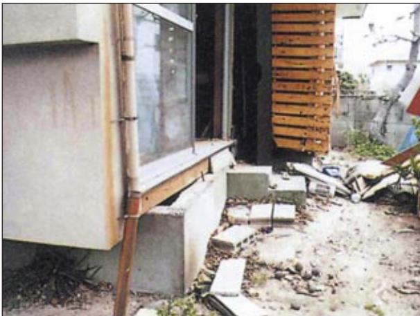
上部構造が基礎から移動している
