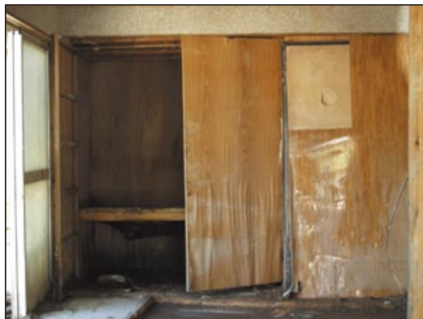
ドア等の面材が膨張し剥離している
