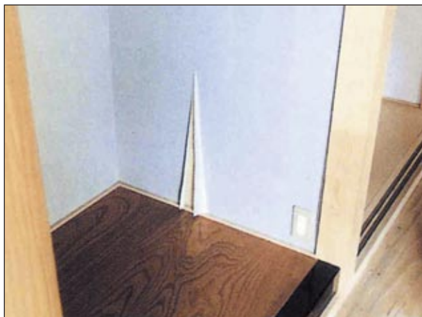
壁クロスの汚損・表面劣化・剥離等が見られる
