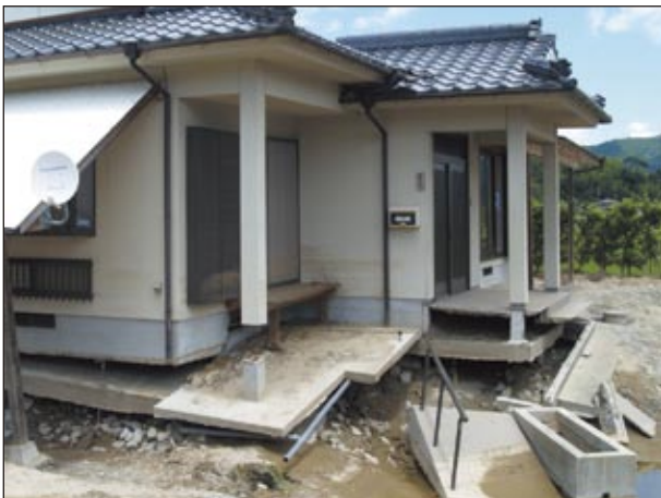
基礎が地盤と共に流出している
