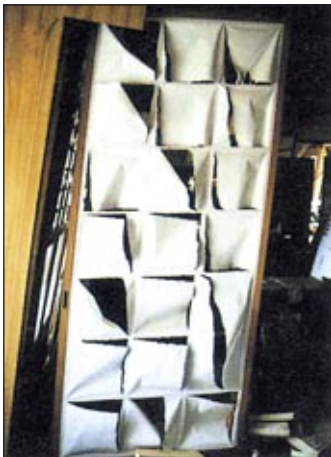
【襖、障子】 かまちの損傷が著しく、交換が必要である
