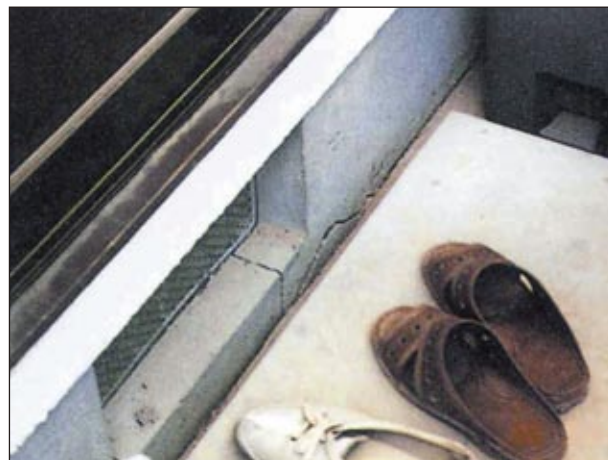
基礎の換気口廻りに亀裂が見られる
