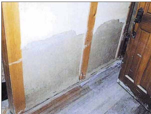
仕上塗壁材の剥離等が見られる
