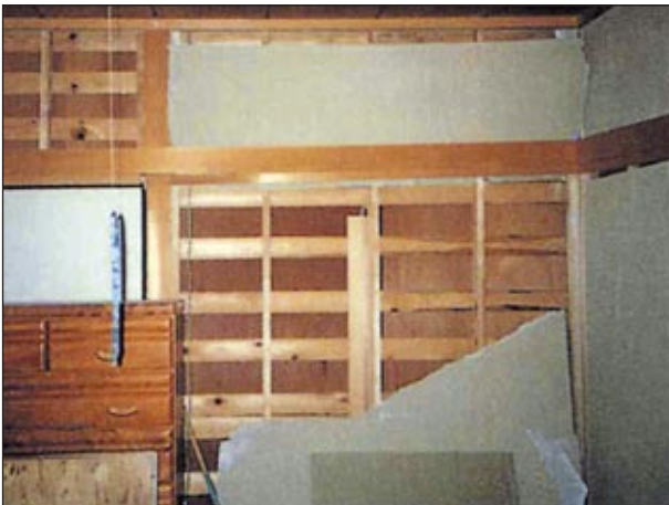
全ての仕上材が脱落している
