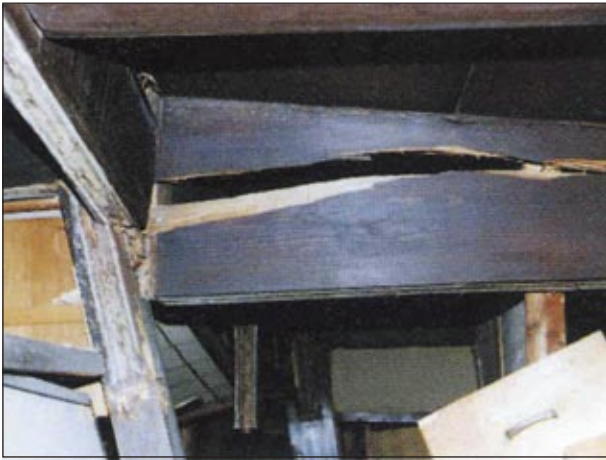
柱、梁に大きな割れが見られる
