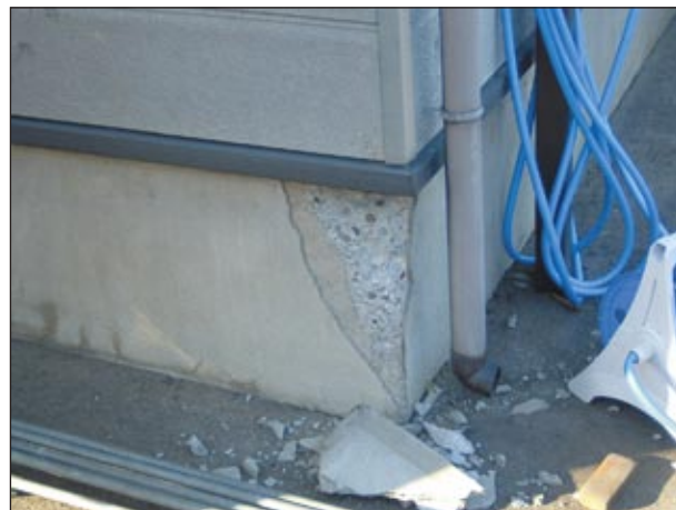
基礎の仕上モルタルの剥離及び基礎躯体自身の欠損脱落が見られる
