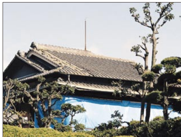
棟瓦以外の瓦もずれが著しい
