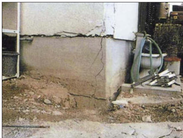
基礎の出隅部分に亀裂が見られる
