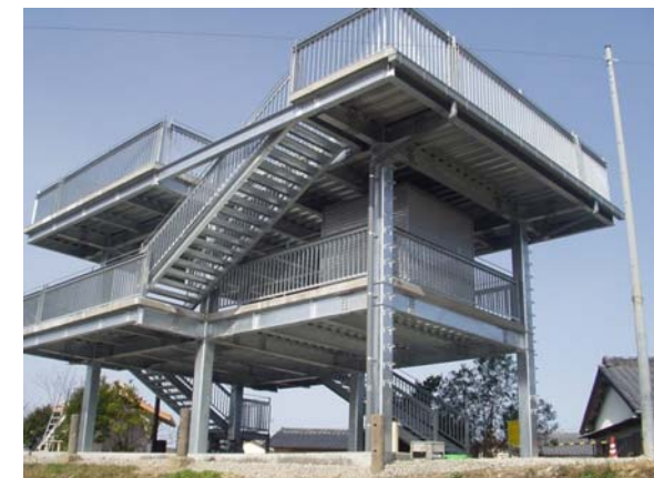
〔津波避難タワー〕
