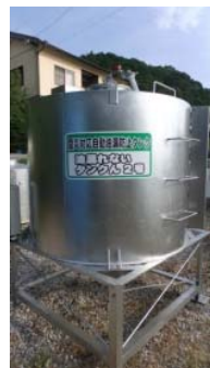
〔流出防止装置付き重油タンク〕
