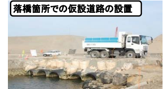
■被災と道路啓開のイメージ
