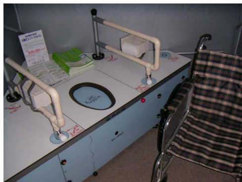
車椅子対応の仮設トイレ
