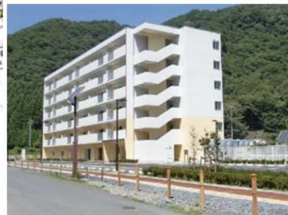
住宅再建の支援、復興公営住宅(釜石市)
