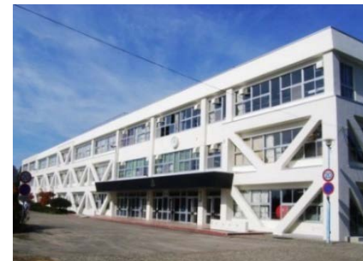
学校の耐震補強
