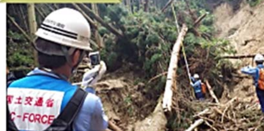
【 H26.8 広島土砂災害 】 (広島県広島市)
