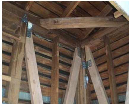
住宅の耐震補強
