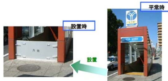
地下街や地下鉄入口における 止水板の設置
