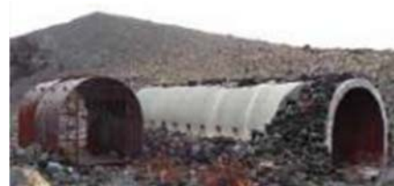
火山シェルターの整備
