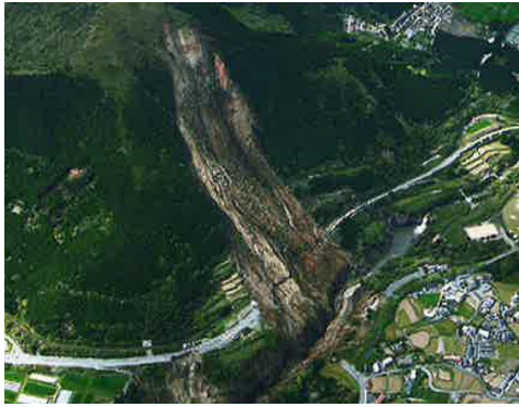
斜面崩壊による道路寸断と落橋 (国道 57 号・国道 325 号 阿蘇大橋付近)
