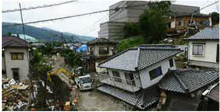
家屋の倒壊 (益城町)
