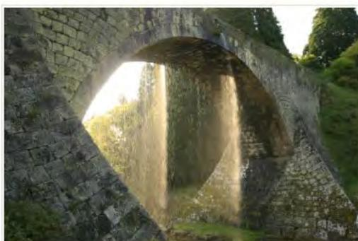
写真1 熊本地震直後の漏水状況(1)
