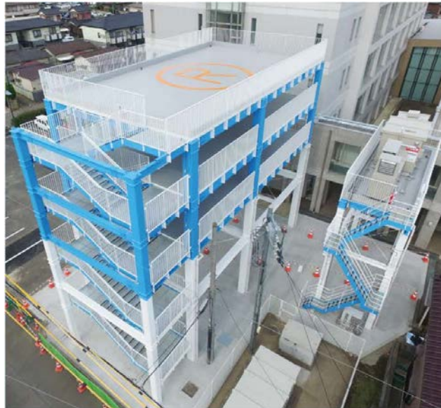
図 境町水害避難タワー
