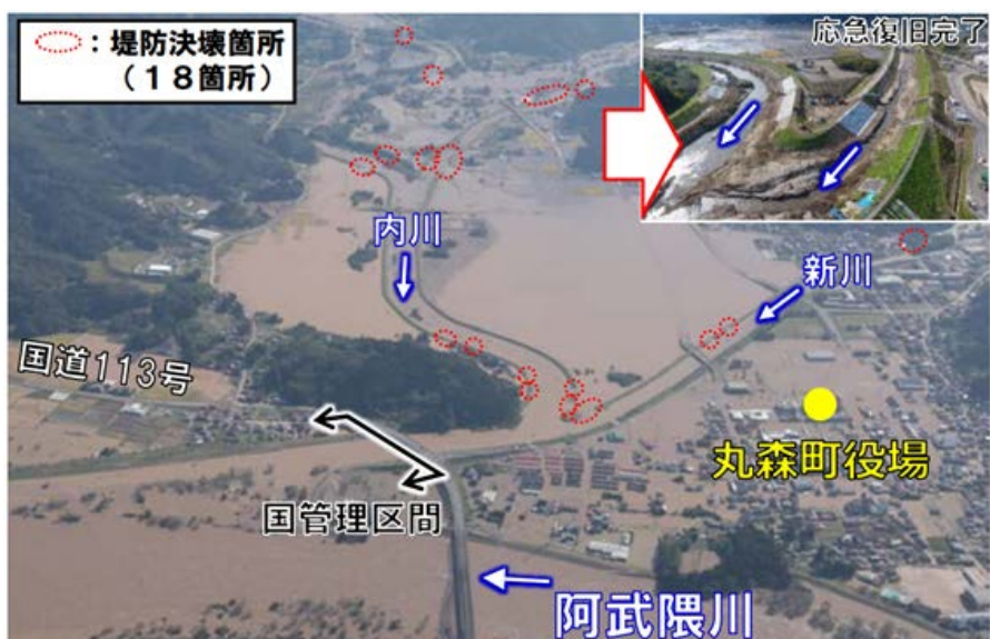
図 被災状況と復旧状況（宮城県）
