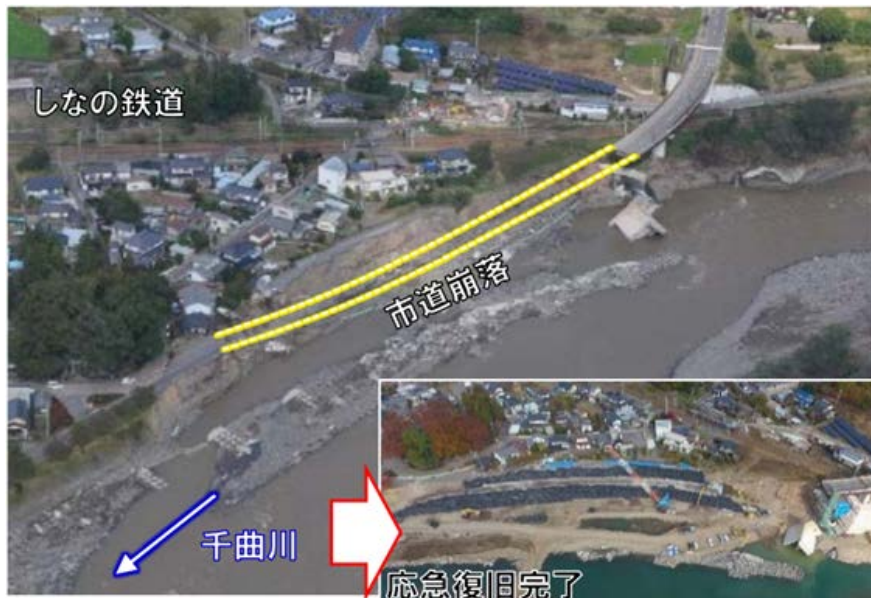
図 被災状況と復旧状況
